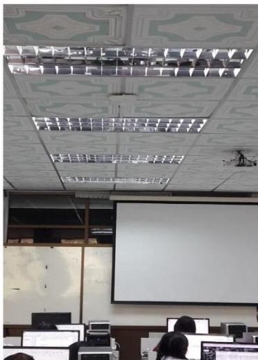
Name : AP – 121 Install : ICT Floor : 2
